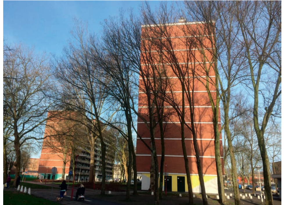
De twee nog te slopen flats van Vidomes
